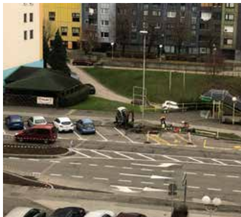
Ponovno razkopavanje sveže pobarvanega dela ceste
