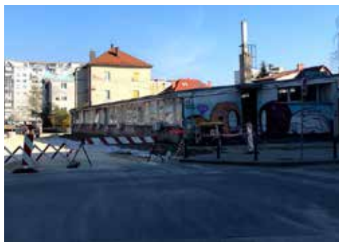
Razkopan odsek Jezdarske ponuja priložnost, da komunalni vodi uredijo tudi za prihodnjo gradnjo zdravstvenega doma
